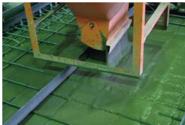
ESCONスラブの打設状況
