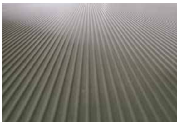
ESCONデッキ表面の凹凸形状
