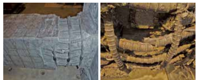
かぶりコンクリートを取り除き鉄筋切断状況を撮影
