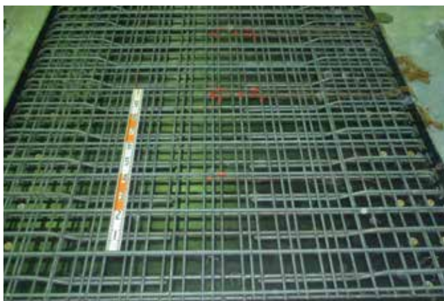
ESCONスラブの鉄筋配置状況
