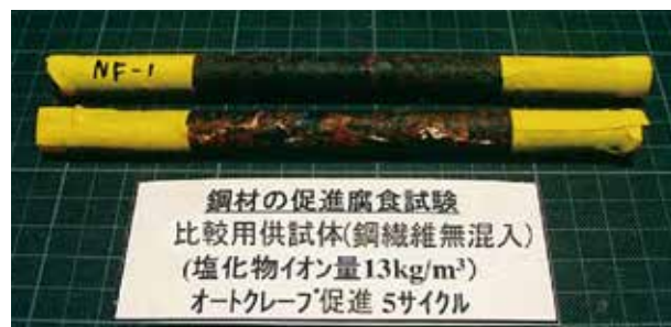
腐食促進試験後の鋼材状況(早強ポルトランドセメント) (参考)
