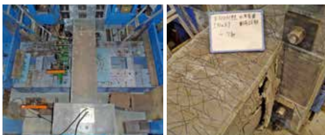
繊維により補強されており、かぶりコンクリートが剥落しない
