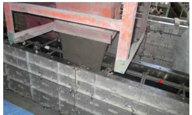
供試体打設状況
