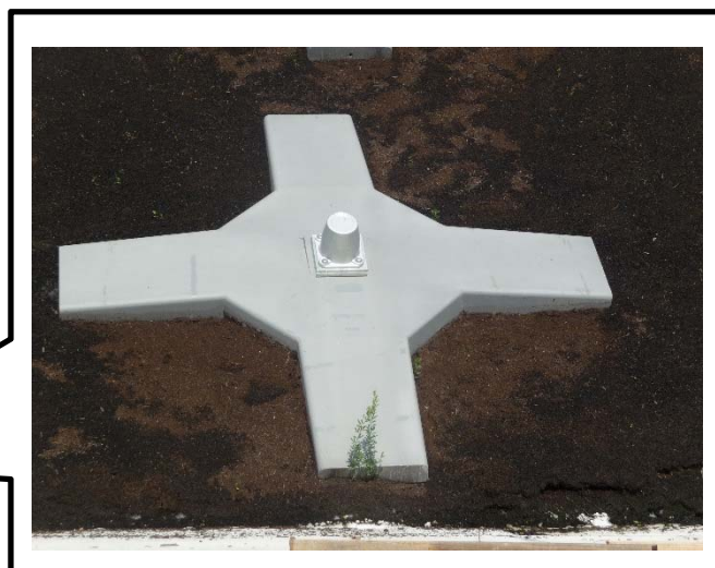
ESCON受圧板設置状況（植生機材吹付け後）
