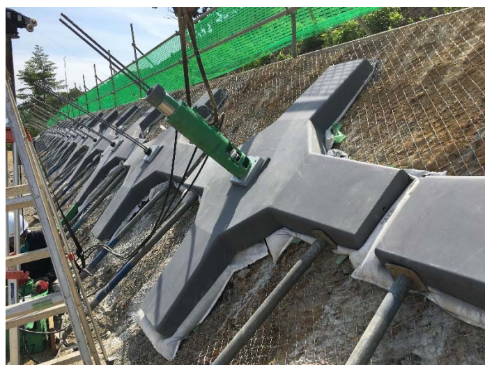
アンカー材緊張状況
