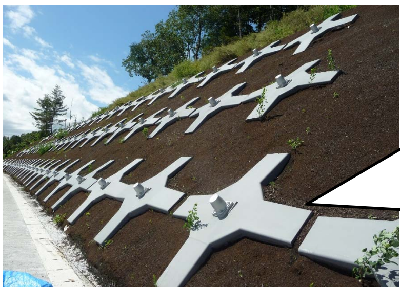
ESCON受圧板設置状況（植生機材吹付け後）
