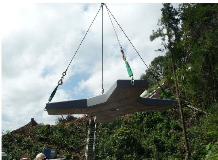
ESCON受圧板吊上げ状況
